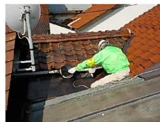
建築組合による家屋修繕ボランティアのようす(三隅)
