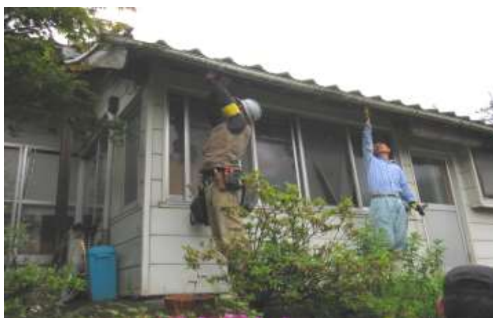
建築組合員による住宅改修のようす
